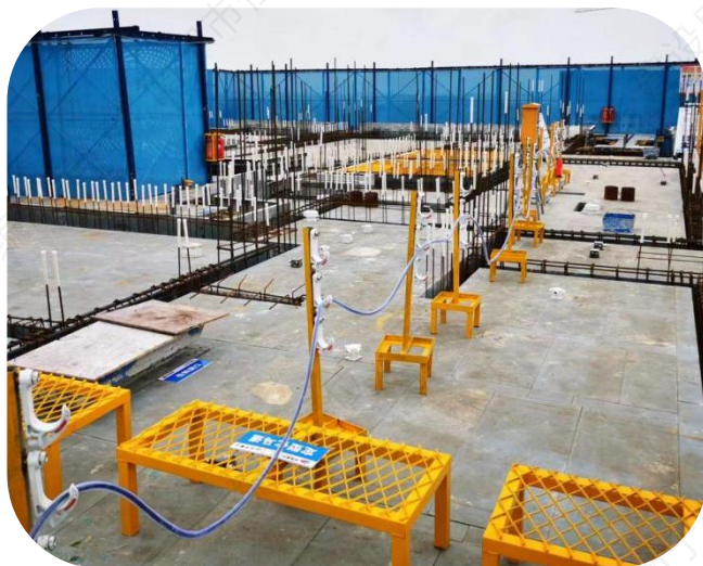
带底座挂钩式电缆支架
