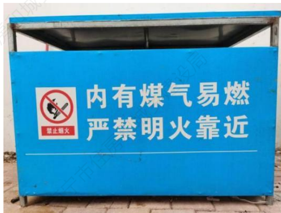
燃气罐单独存放间
