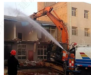
拆除湿法作业
