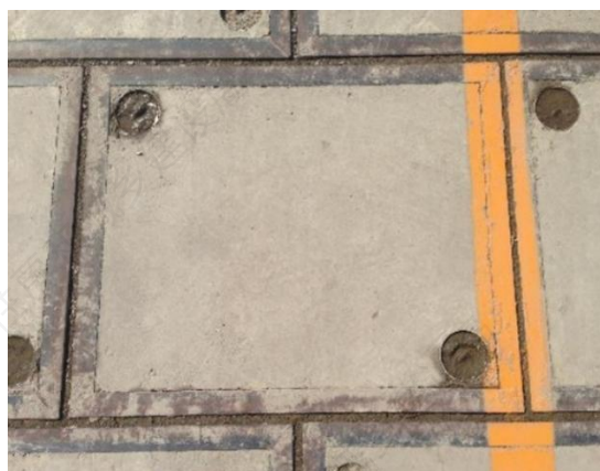
预制混凝土板硬化道路
