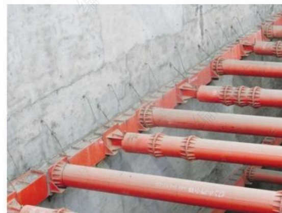
挂网喷浆护壁平整度
