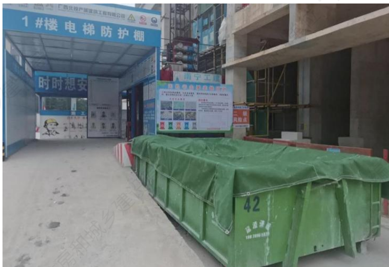
示例 8 斗车式无机非金属类堆放区
