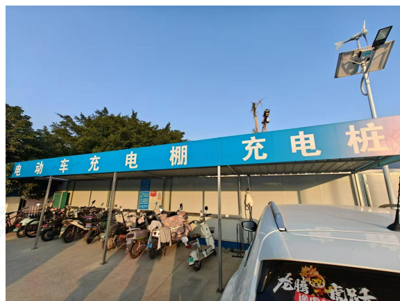
电动车充电桩
