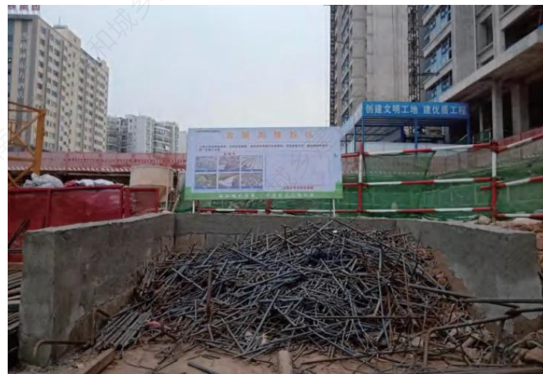
示例 9 砌砖式金属类堆放区
