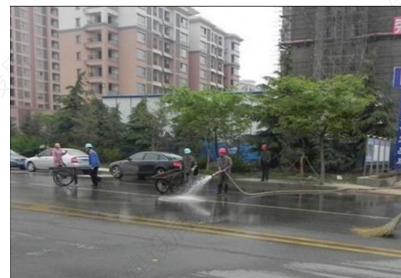
对工地出入口道路50米范围内进行不间断清扫
