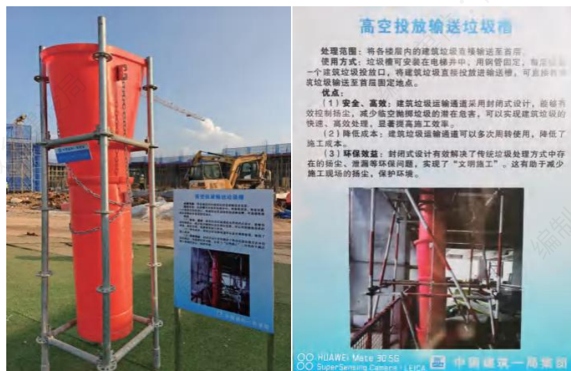
示例 12 高空投放输送垃圾槽
