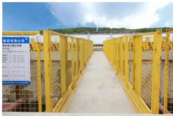
混凝土支撑防护
