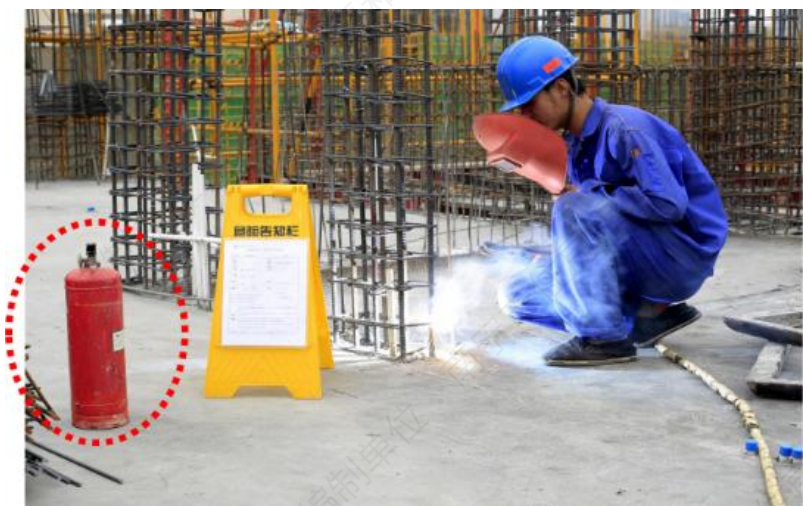
水电班组动火作业
