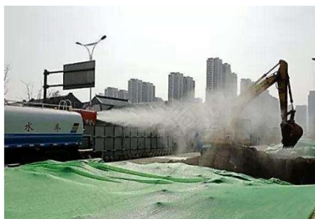
土方湿法作业
