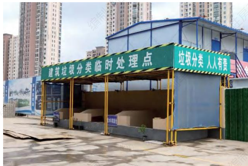
示例 7 建筑垃圾分类临时处理点
