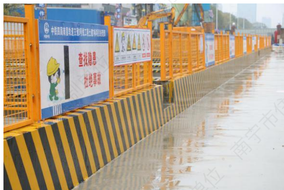
基坑临边防护
