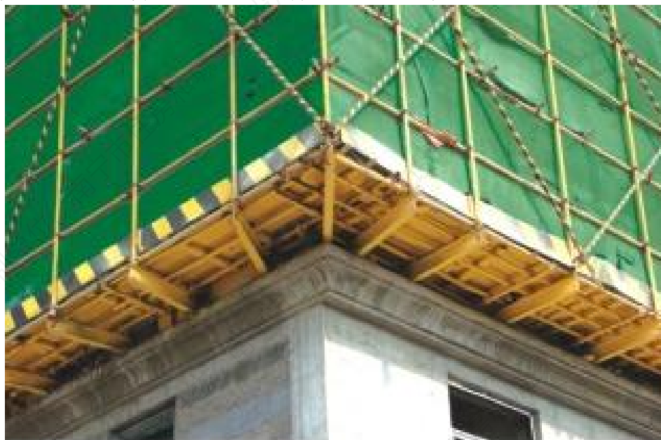
脚手架底层封闭示意图
