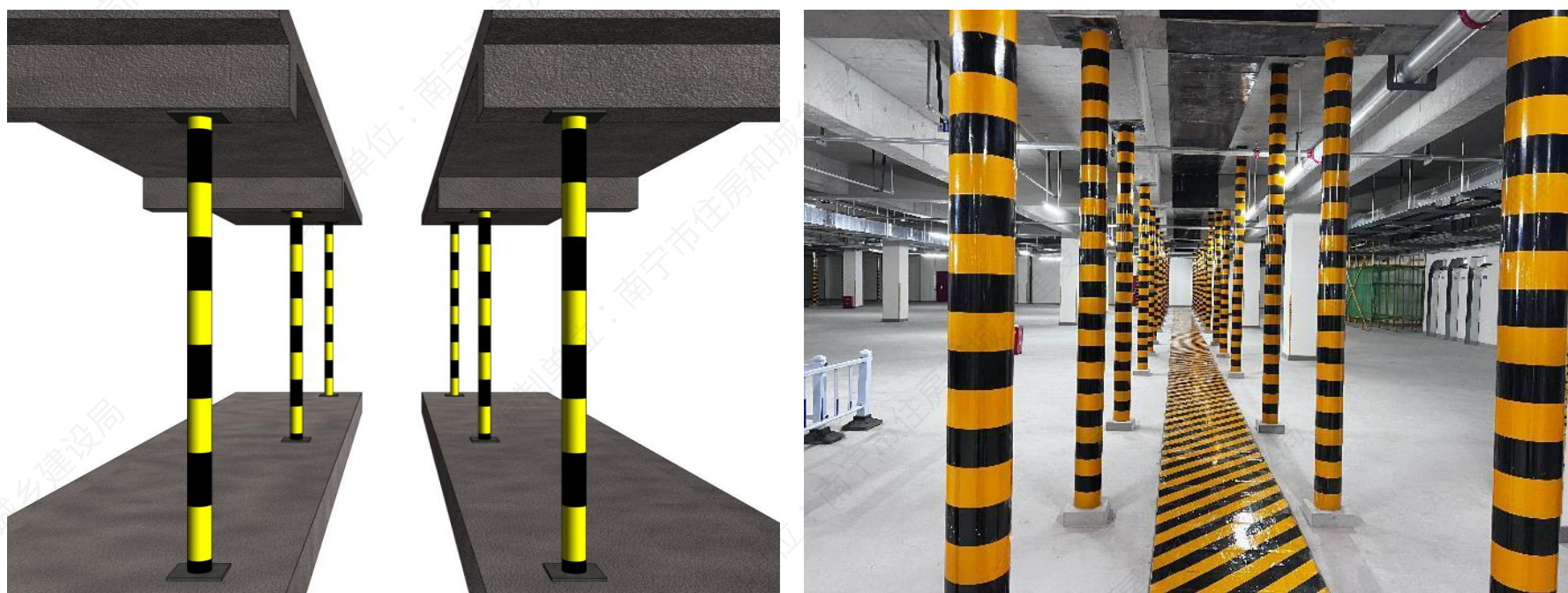
后浇带圆钢管独立支撑体系立面图
