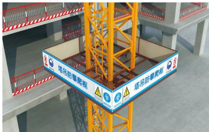
塔吊防攀爬装置
