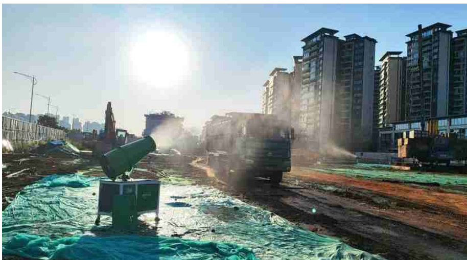
场内道路每20米一台雾炮机喷淋覆盖，保持道路湿润
