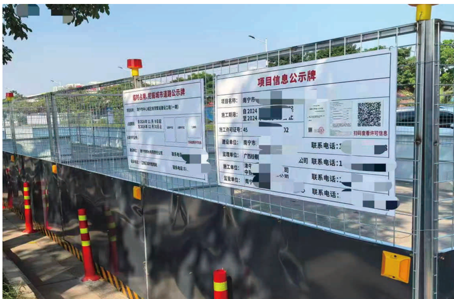
市政临时围挡现场设置
