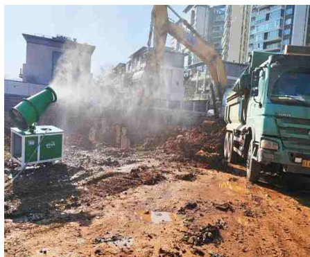
挖掘区域雾炮机喷淋覆盖
