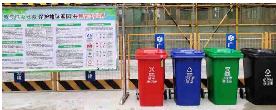
施工现场生活垃圾分类
